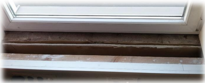
Klassenzimmer 1 Detailpunkt Fensterbank (fehlend)
