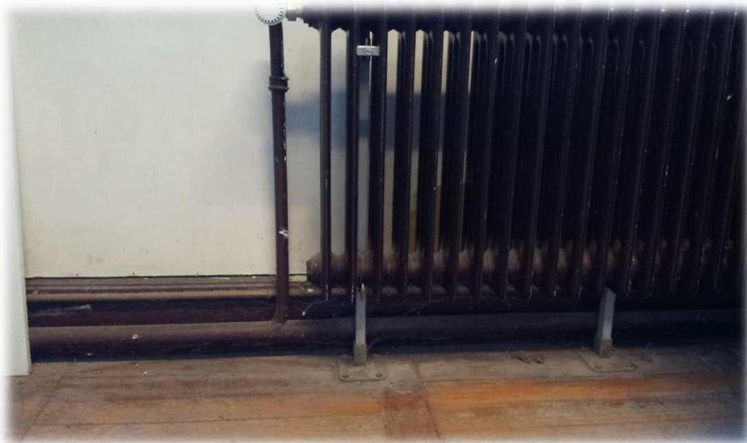
Das kleine „Lehrzimmer“ Detail Fußboden und Heizung
