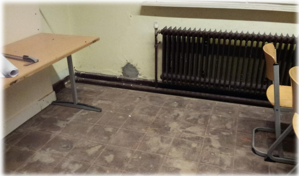
Klassenzimmer 2 Detail Fußboden und Heizung
